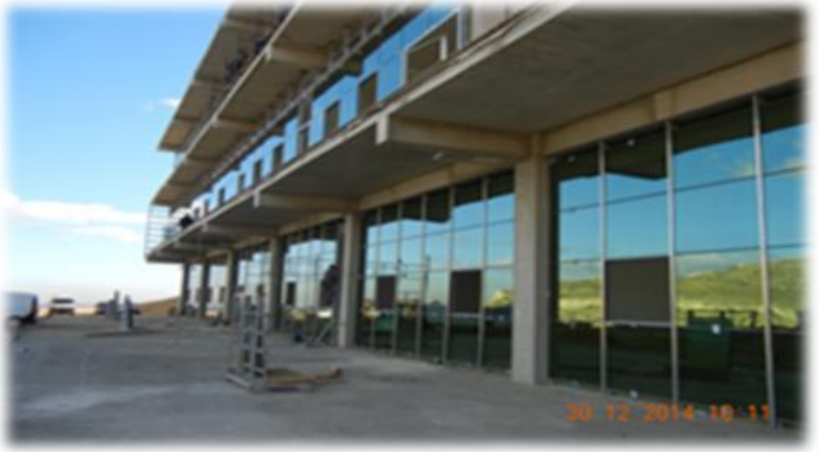
Resim-2: Gastronomi Mutfağı ve Atölye Binası inşaatı
